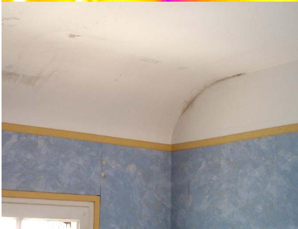
Problème d'isolation en bordure de toiture d'une lucarne rampante. Il y a déjà eu de la condensation : le papier peint est dégradé dans l'angle, et il y a ses traces de moisissures nettoyées.
